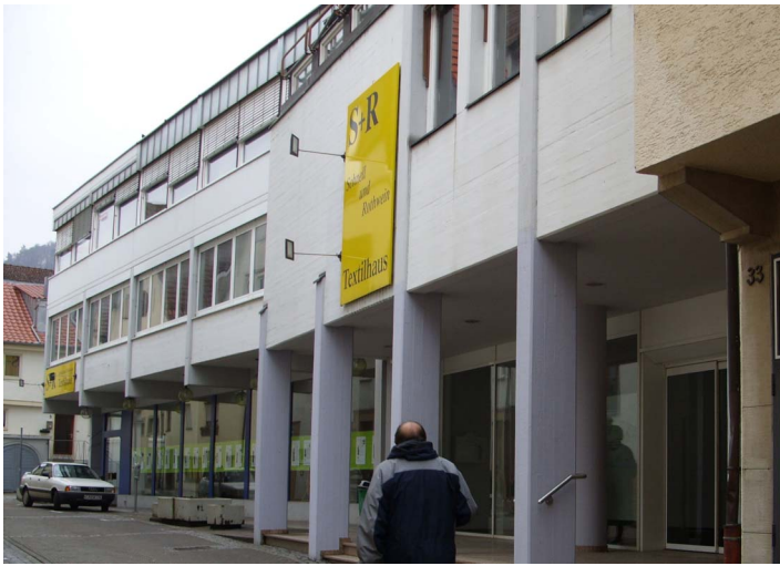
Das Peka-Areal zwischen Keltergasse (Foto) und Konsul-Uebele-Straße
